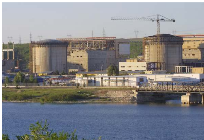
FIG. 3. Cernavoda Units 3 and 4 actual status.
