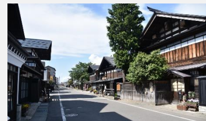
電線類地中化工事
