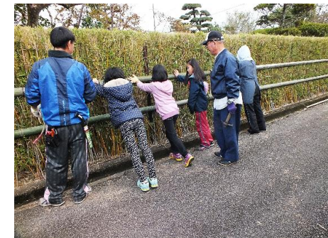
押縁を表裏両側から押さえ針金で固定する作業
