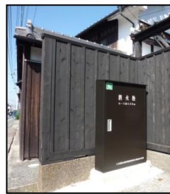
防災施設整備
