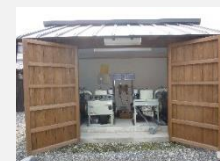
ポンプ格納庫
