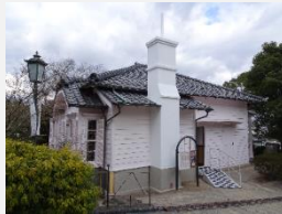
耐震補強: 旧ウォーカー住宅
