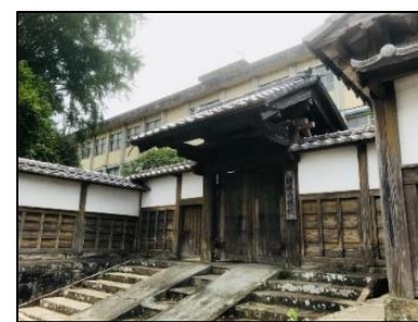
<出水御飯屋門修理工事>
