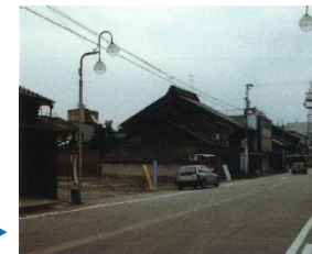
(店舗解体・更地)
