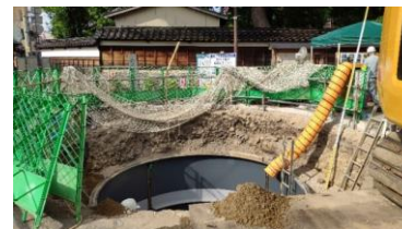
防火水槽工事中
