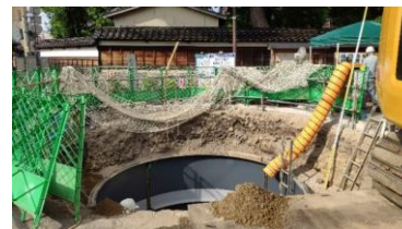
防火水槽工事中
