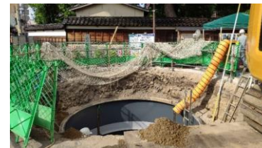
防火水槽工事中
