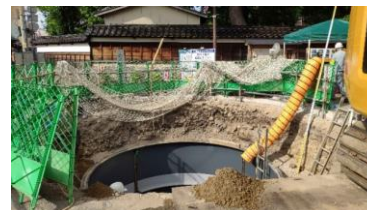
防火水槽工事中
