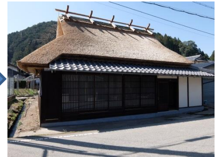
修理後(福住地区)
