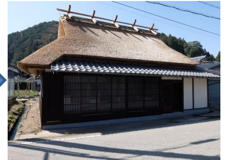
修理後(福住地区)
