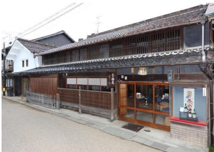
町屋が建ち並ぶ本町通り
