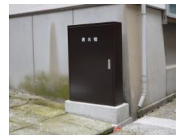
消火栓(温泉津地区)
