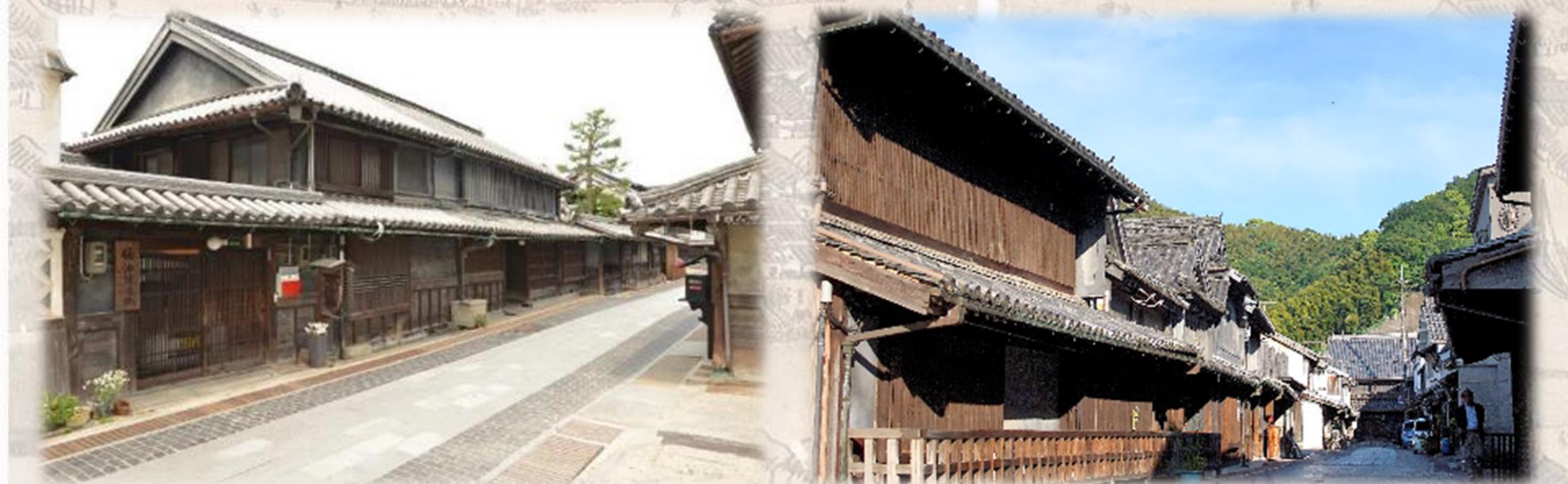
元禄4年（1691）建築の旧吉井家住宅
