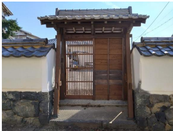
旧O家門修理
