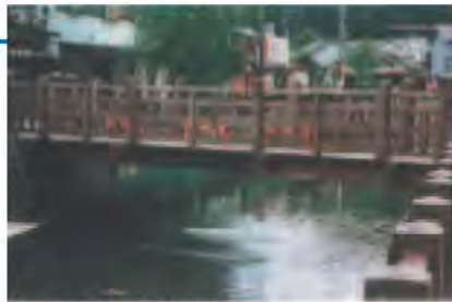
古い街並のなかにある樋橋
