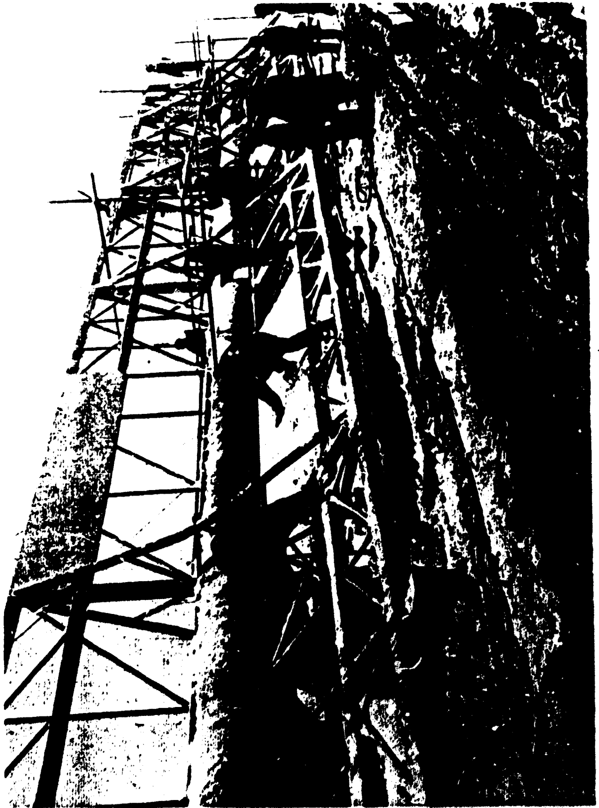
Fig. 3-3. — Cheminée sur son bergeau d'assemblage.
