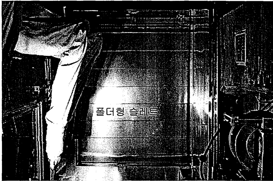
그림 9. 핫셀에 설치되어 구성된 제염체임버 (단힌경우).
