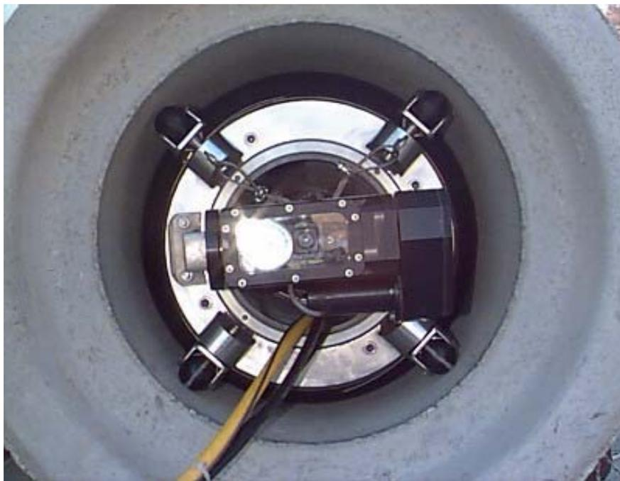
그림 5-5. 하수관 속에 투입하여 공기를 넣은 후의 모습
