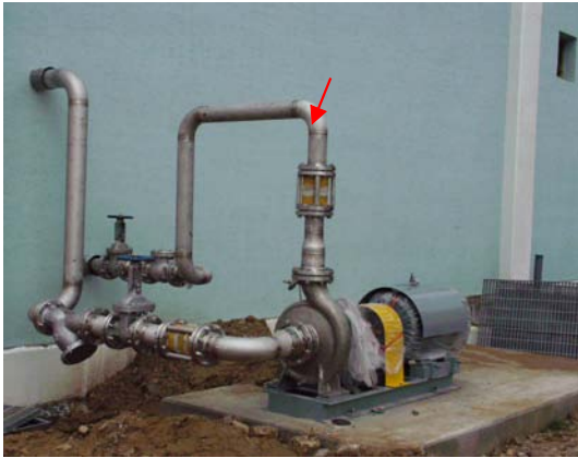
그림 1-4(d) 4" 공급관 하류, 펌프, 4" 배관에 연결된 밸브형상
