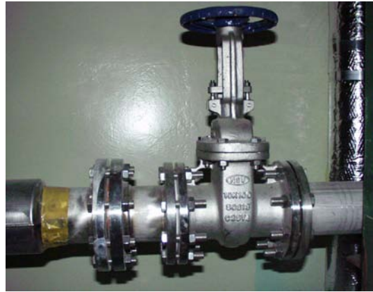
그림 1-4(d) 4" 공급관 하류, 펌프, 4" 배관에 연결된 밸브형상
