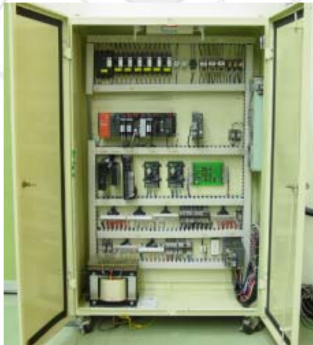
그림 5 원격제어를 위한 PLC 제어판
