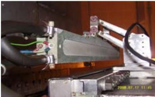
그림 19. Beam scanning monitor 교체
