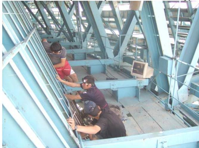
Рис.1. Процесс юстировки facets концентратора БСП, модернизированным методом обскуры.
