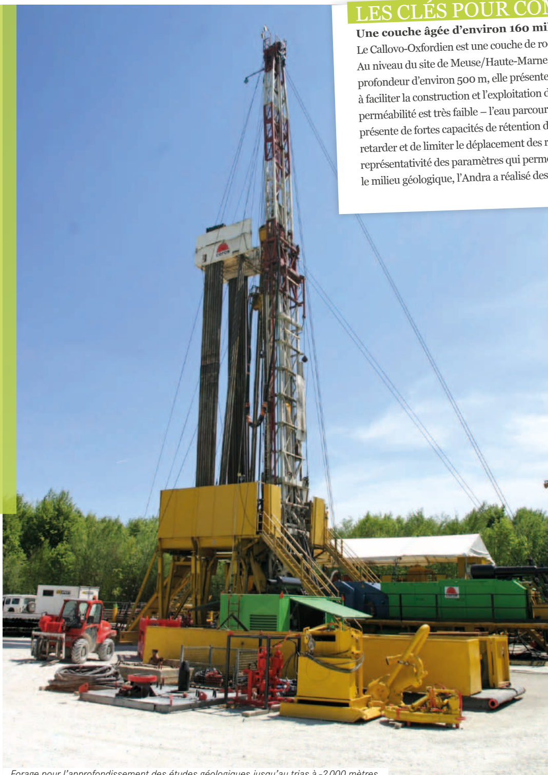
Forage pour l'approfondissement des études géologiques jusqu'au trias à -2000 mètres.
