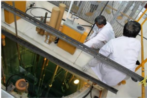
**Gambar 3.** Proses pemuatan bahan bakar ke dalam teras reaktor Kartini
