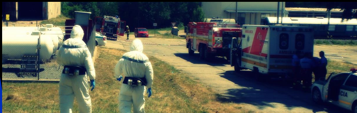
Demontáž a odvoz rádioaktívnych žiaričov firmou Huma-lab Apeko, s.r.o.
