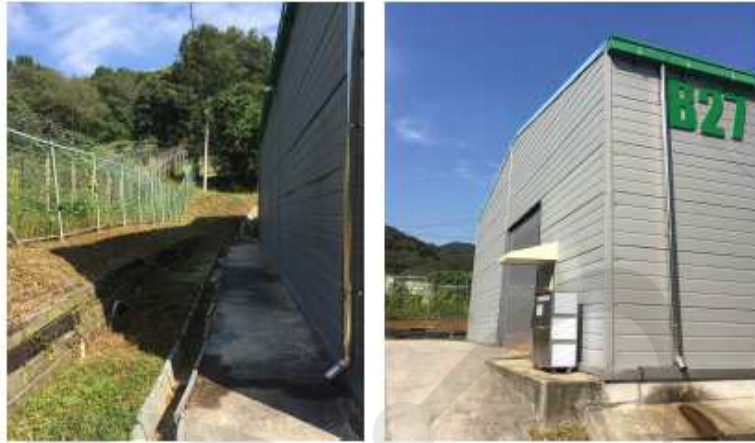
<서울연구로 해체폐기물 보관중인 가연물처리동 건물(B27)>
