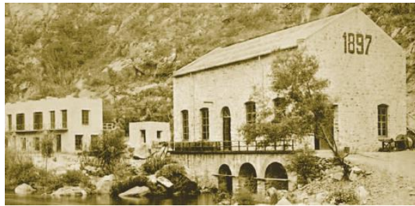
Figura 2: Usina Casa Bamba en la provincia de Córdoba
