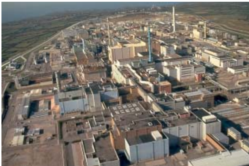
Fig. 1. L'usine AREVA de La Hague.
