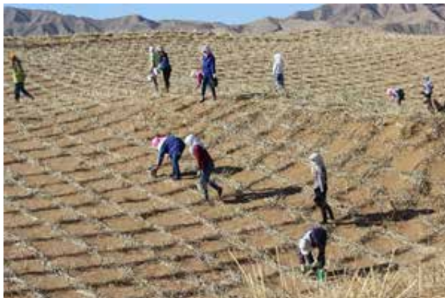
图 18 宁夏中卫构建防风固沙体系（草方格）
