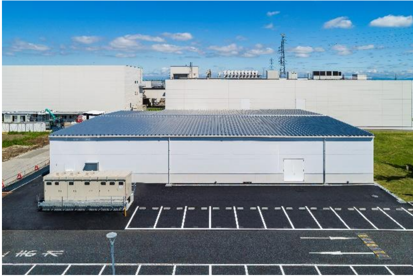
2号棟別館 2024年4月30日竣工
