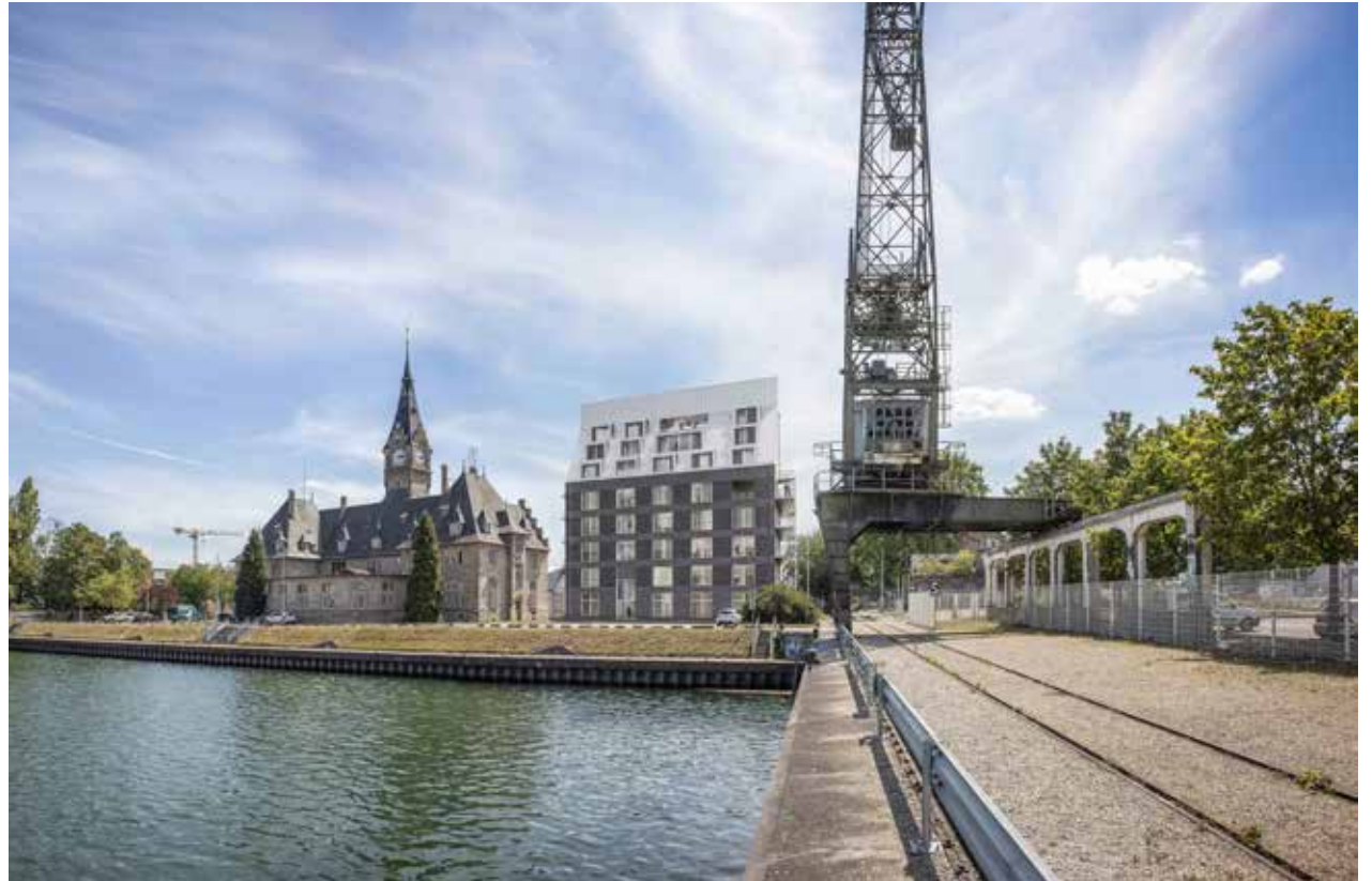
La Maison de la Virgule vue depuis le Bassin du Commerce, dans le port de Strasbourg. À gauche, la capitainerie © Lucquet architectes
