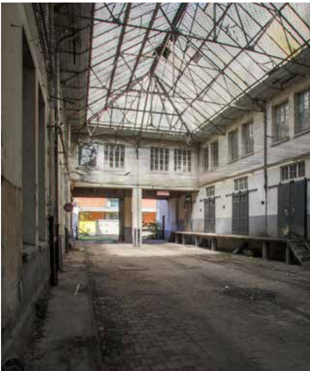
La verrière avant travaux - Photo Philippe Groslier
