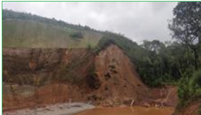
Vista do deslizamento provocado pelas chuvas
