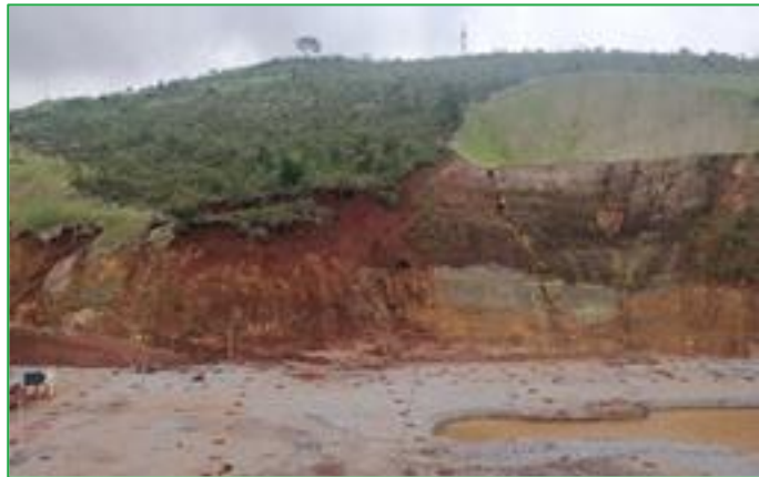
Área para intervenção emergencial
