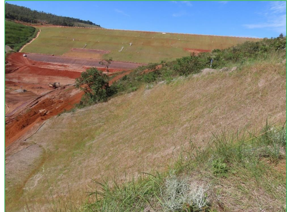
Vista da área de intervenção com solo exposto
