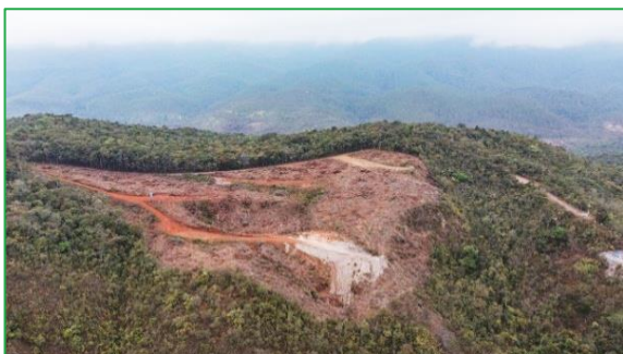
Área da torre 2
