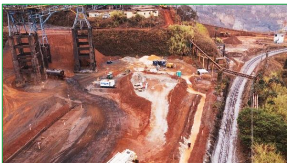
Área da torre 4
