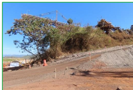
Acessos não pavimentados e outras estruturas minerárias
