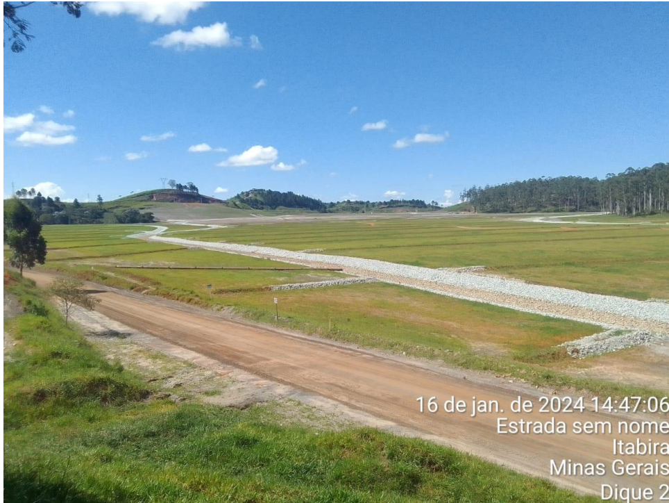
Foto 12. Recomposição da vegetação finalizada em outubro de 2023 – Dique 2. Fonte: Vale, 2024. Nota-se o sucesso da metodologia de plantio empregada e que não há solo exposto no local.
