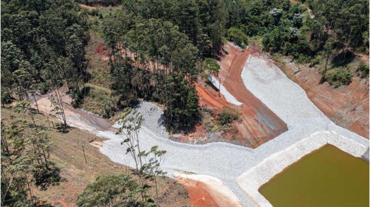
Foto 1. Canais de drenagem de água para o sump- Dique Minervino. Fonte: Vale, 2024.
