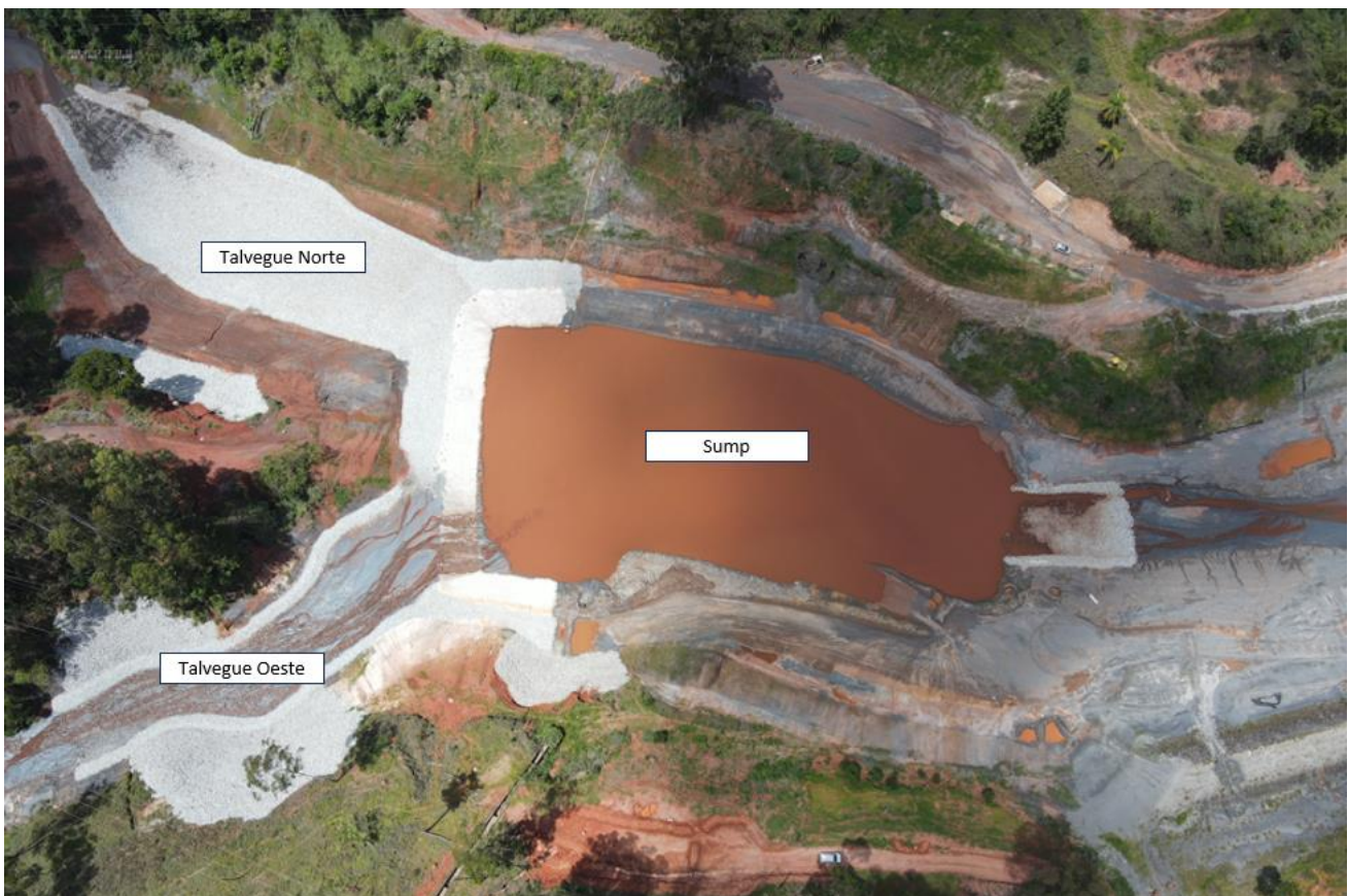
Figura 3. Sump – Foto de 12/01/24 – Execução da Sump .
