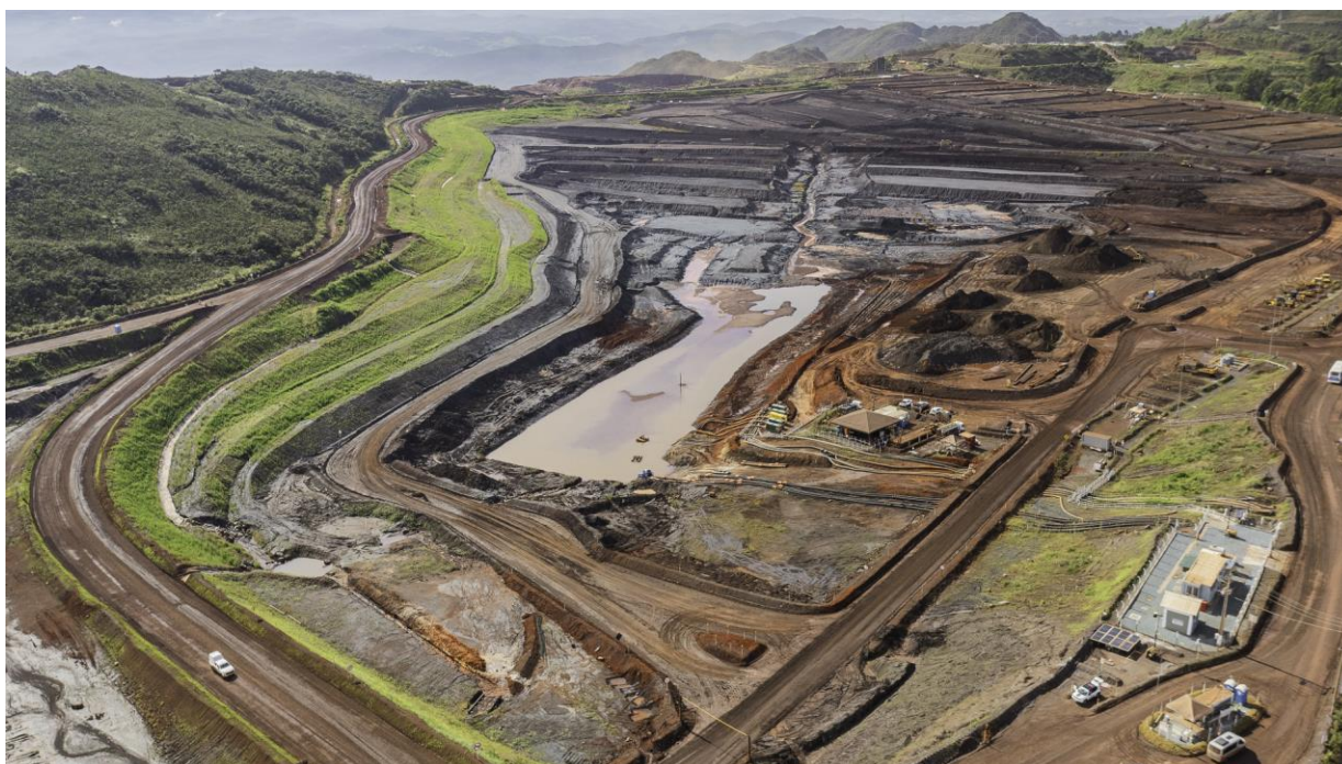
Figura 19 - Vista da Barragem Vargem Grande, após processo de revegetação bem estabelecido da ombreira esquerda da barragem. (Fonte: Vale, 01 de abril de 2024).
