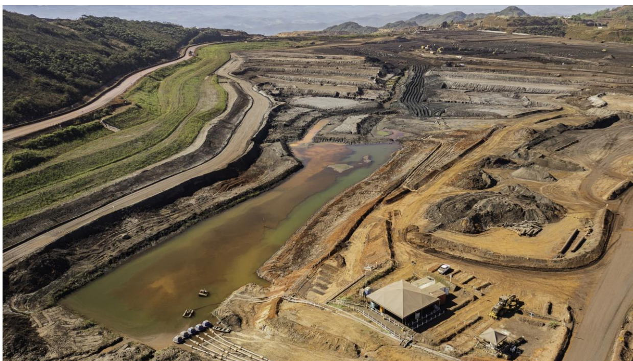
Figura 21 - Vista da Barragem Vargem Grande, após processo de revegetação bem estabelecido da ombreira esquerda da barragem – período de seca. (Fonte: Vale, 06 de junho de 2024).
