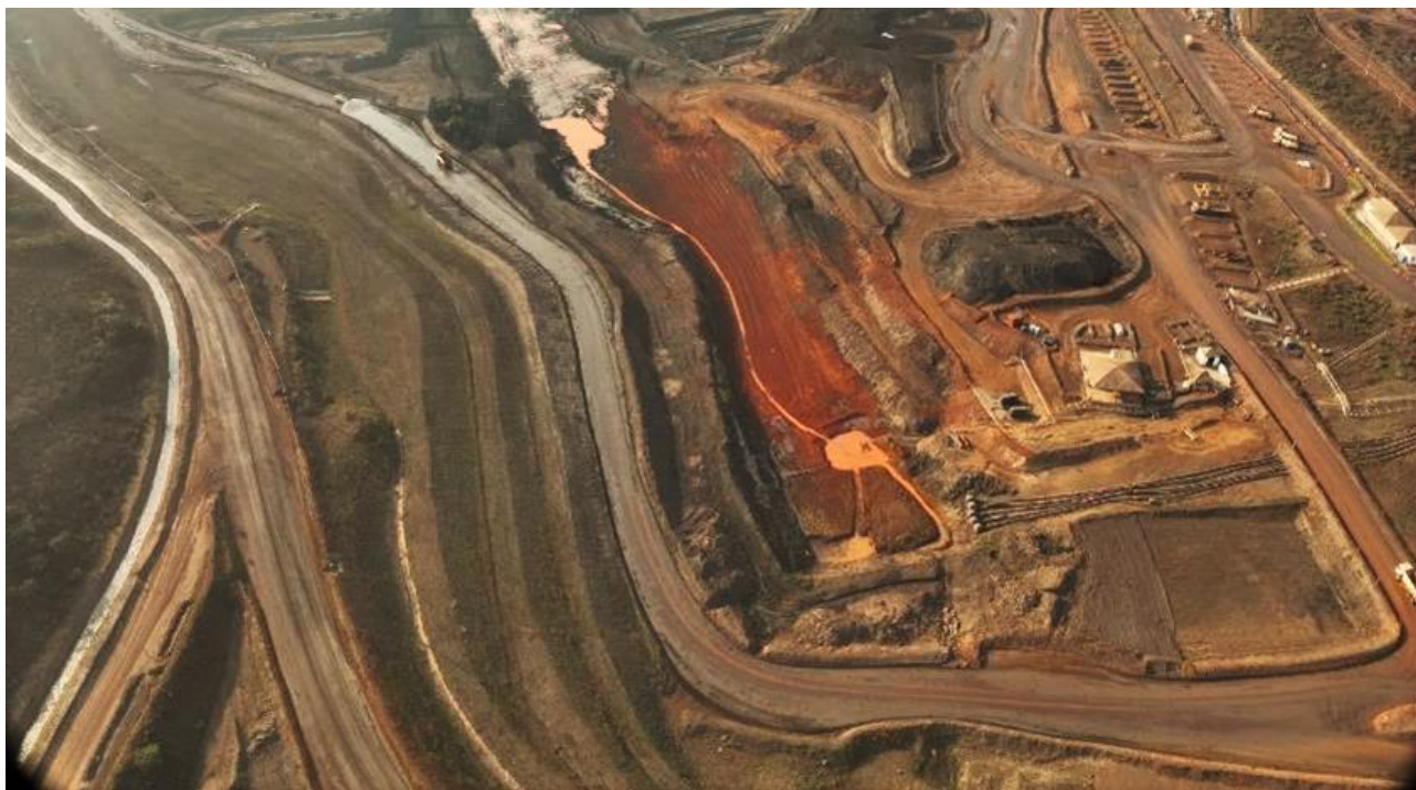
Figura 10 -Vista do Sump de drenagem do reservatório com o sistema de bombeamento operantes e obras de preparação para o período chuvoso (27/09/2024).
