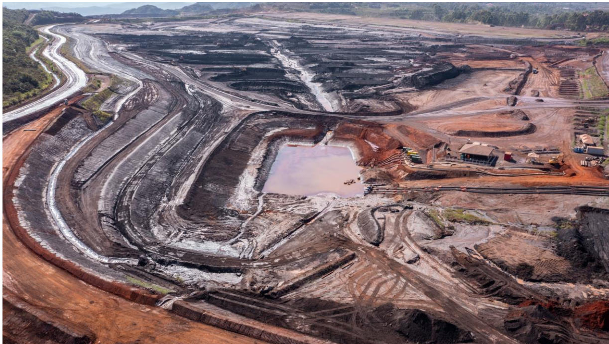
Figura 18 - Vista da Barragem Vargem Grande, com foco na ombreira esquerda, durante o período de aplicação de MVP (Fonte: Vale, 01 de dezembro de 2023).
