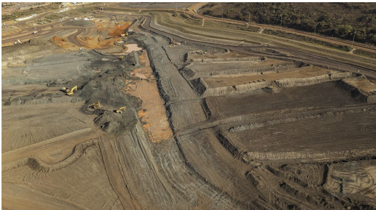
Figura 24 - Vista da Barragem Vargem Grande, após processo de revegetação bem estabelecido da ombreira esquerda da barragem – período de seca. (Fonte: Vale, 27 de setembro de 2024).
