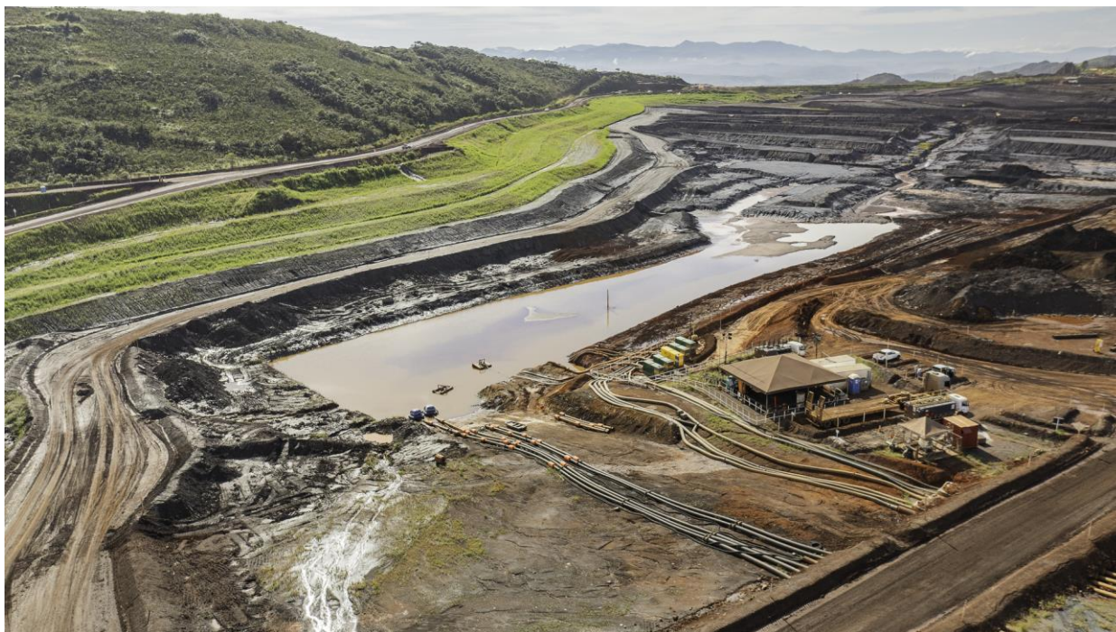
Figura 20 - Vista da Barragem Vargem Grande, após processo de revegetação bem estabelecido da ombreira esquerda da barragem. (Fonte: Vale, 01 de abril de 2024).
