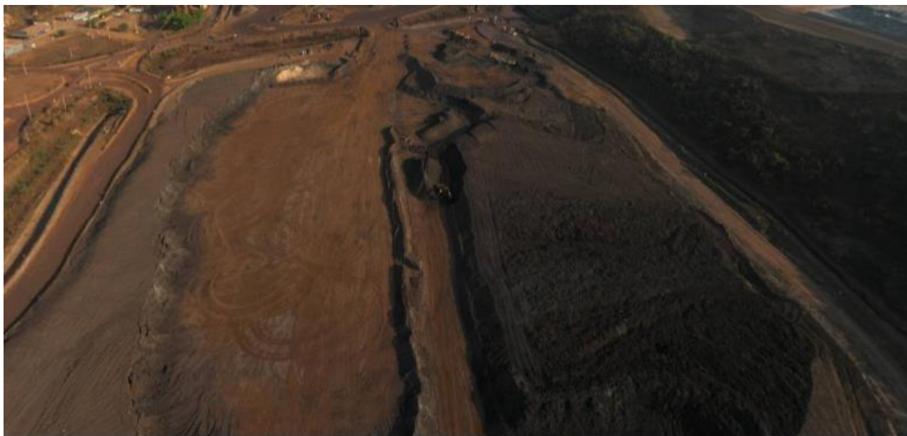
Figura 12 -Visão geral de estocagem temporária na pilha para desaguamento (27/09/2024).
