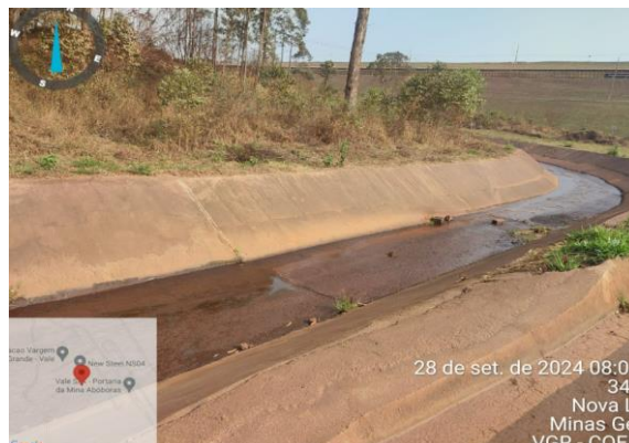
Figura 17 - Inspeção para avaliar condição de limpeza no canal de cintura CC02 (Fonte: Vale, setembro de 2024).
