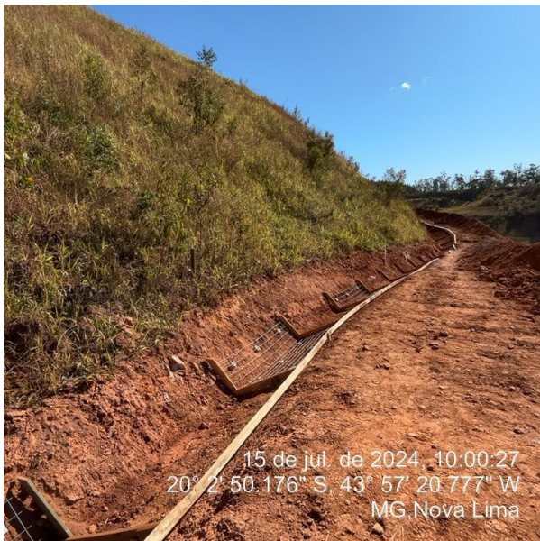
Foto 5. Execução de canaletas na ombreira direita - Obras de execução do PRAD. (Fonte: Vale, julho de 2024).
