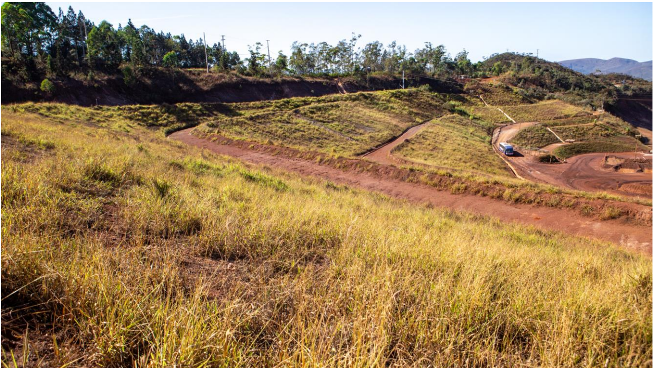
Foto 9. Processo de revegetação através de aplicação de MVP bem estabelecida – período de seca. (Fonte: Vale, 08 de julho de 2024)
