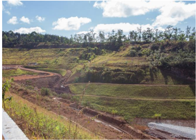
Foto 8. Revegetação bem estabelecida na ombreira esquerda – período de seca. (Fonte: Vale, 08 de julho de 2024).
