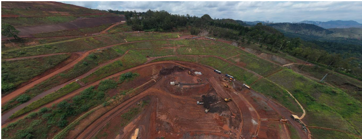
Foto 14. Vista da PDE-X após processo de revegetação bem estabelecido das ombreiras da barragem. (Fonte: Vale, 29 de janeiro de 2024).
