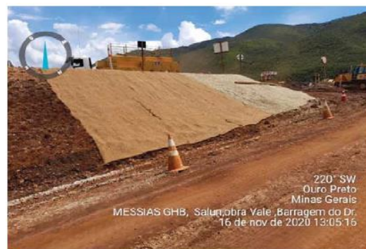
Obras de implantação do sistema extravasor da barragem Doutor
