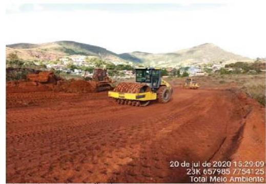
Obras de implantação do sistema extravasor da barragem Doutor
