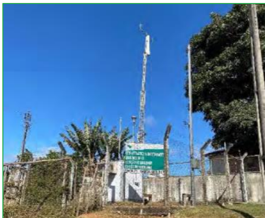
Vista da Estação de Monitoramento
