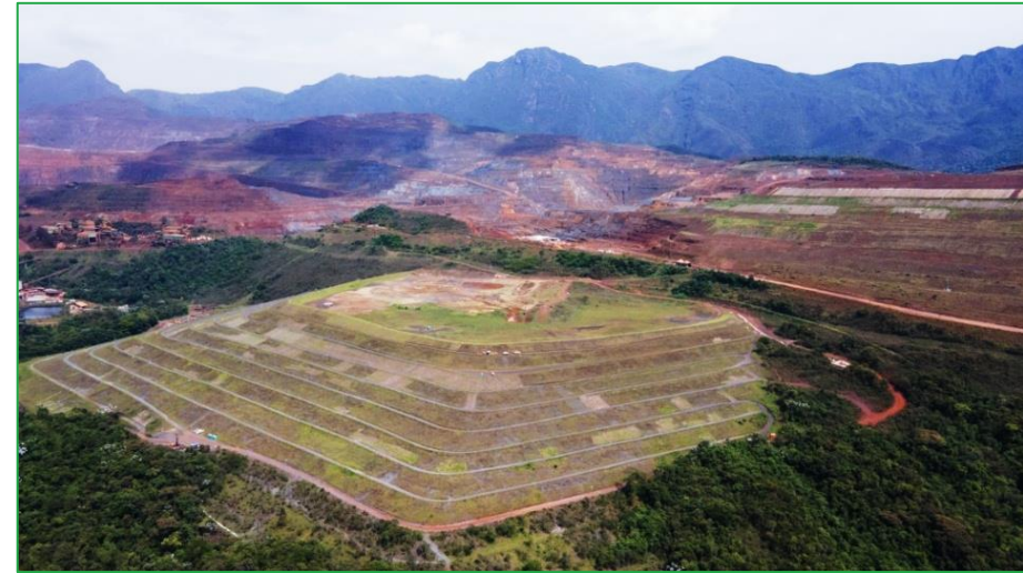
Vista parcial da barragem Xingu - Mina de Alegria
