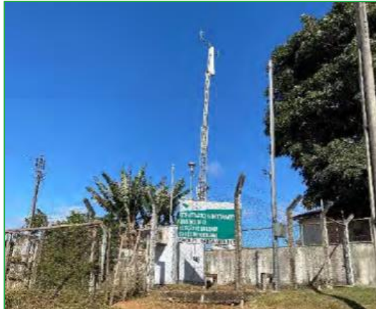
Vista da Estação de Monitoramento
