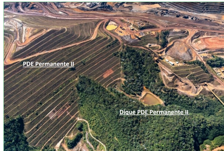
Pilha de Estéril PDE Permanente II e Dique PDE Permanente II
