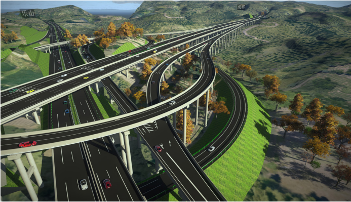
四川路桥使用 OpenRoads 和 LumenRT 对长达 155 公里公路沿线的 17 座立交桥的可视距离问题进行了建模、可视化和校正
