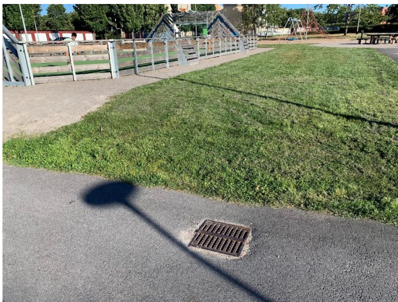
Figur 44. Provtagningsbrunn vid multisportplan.
