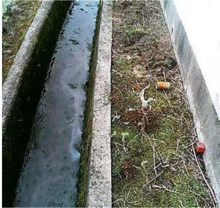
(a) 水路に浮く油①
