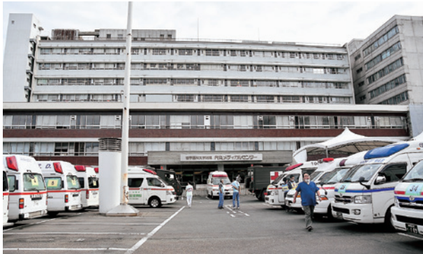
正面エントランスの車両プール
