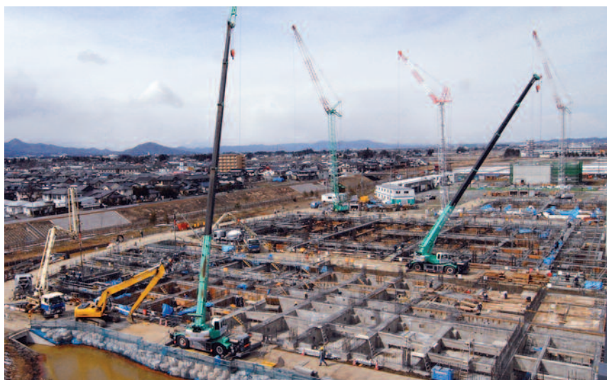
建設が進む総合移転整備計画第二次事業新築工事 (矢巾キャンパスモール屋上から西講義実習棟、西研究棟を撮影 撮影日：3月26日)
