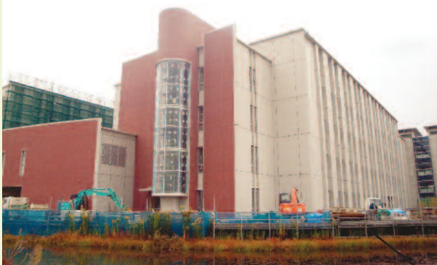
西講義実習棟（南西部から撮影）
